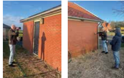
Inspectie dorpshuis Kredo
