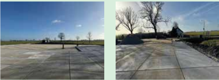
Foto's van de aanleg van de bouwhub in Krewerd t.h.v. Holwierdeweg 28
