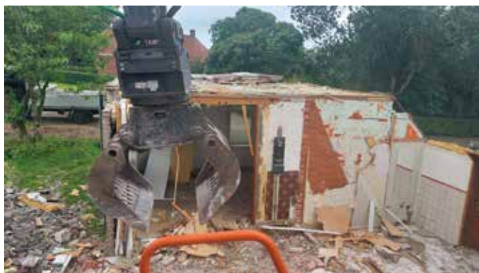
Sloopwerkzaamheden van Kerkpad 10 gestart
